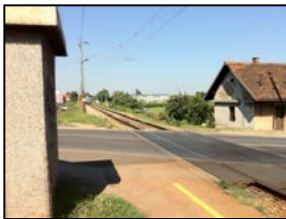
Slika 3.10 Postojeće željezničko stajalište Remetinec (pogled na ŽCP-a)
