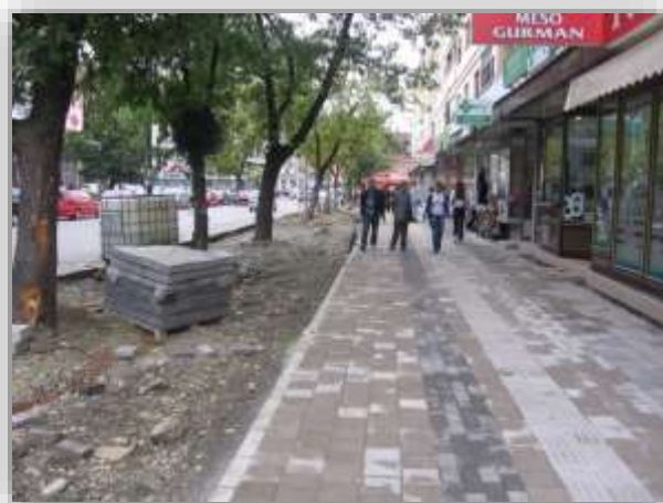
Rekonstrukcije trotoara sa ugradnjom taktilnih ploča
