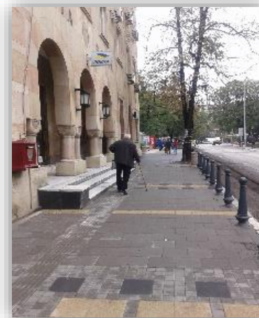
Реконструкције тротоара са уградњом тактилних плоча
