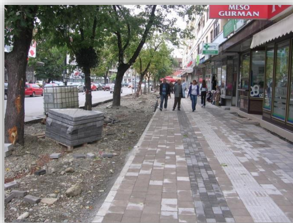
Реконструкције тротоара са уградњом тактилних плоча
