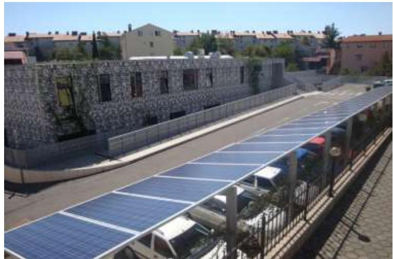
**DV Mavrica** - građen po principima održive korištenjem oborinskih voda za održavanje FNE – 30 kW i solarni paneli za pripremu ventilirajuća fasada
